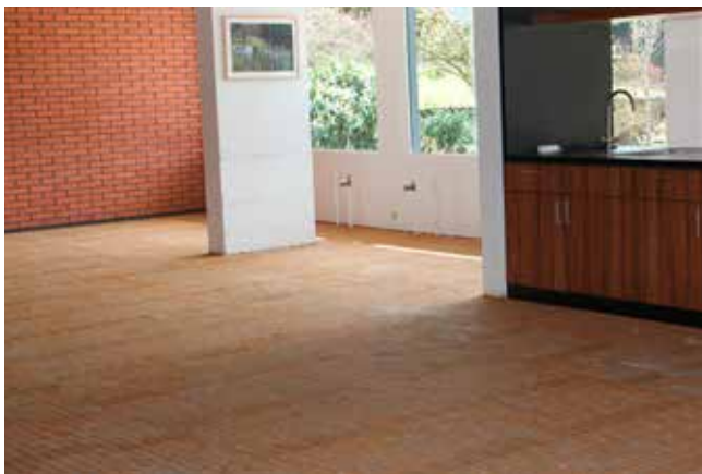
Der Parkettboden im Speisesaal wurde erneuert.
