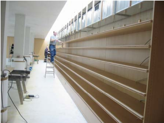
Anfang Dez. 2006: Der Innenausbau beginnt / Early Dec. 2006: Starting on the interior design
