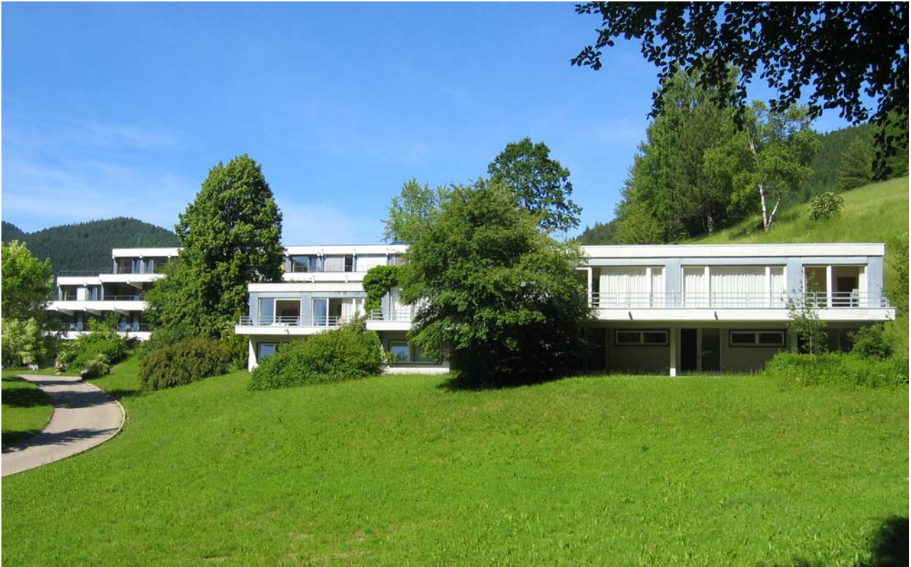
Bungalows und Gästehaus / Bungalows and Guest House
