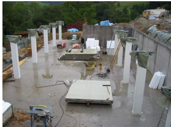
17. – 28.08.2006: Die Wände sowie die Stützen werden gegossen / Casting of the walls and the columns
