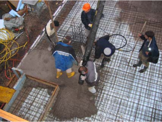
16.08.2006: Die Bodenplatte wird gegossen / Casting of the baseplate
