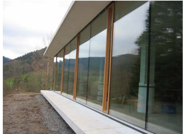
20./21.12.2006: Die Fenster werden eingesetzt / Installation of the windows
