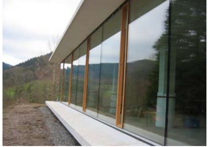
20./21.12.2006: Die Fenster werden eingesetzt / Installation of the windows
