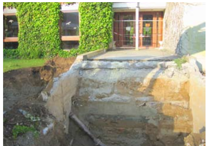
25.05.2006: Beginn Aushub der Baugrube Beginning of the ground excavation
