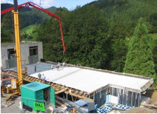
08.09.2006: Gießen der Sichtbeton-Decke / Casting of the fairfaced concrete ceiling
