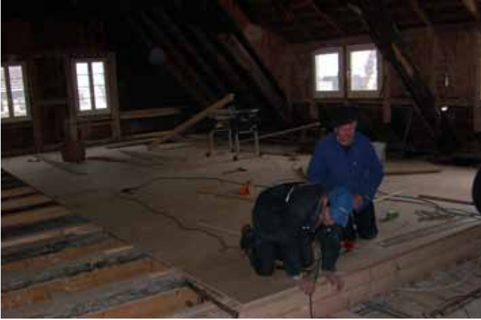
Arbeit der Zimmerer im Dachgeschoß Carpenters at work in the rooftop
