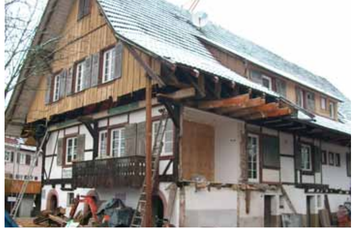
Abriss einer Museumsseite Demolition of one side of the museum
