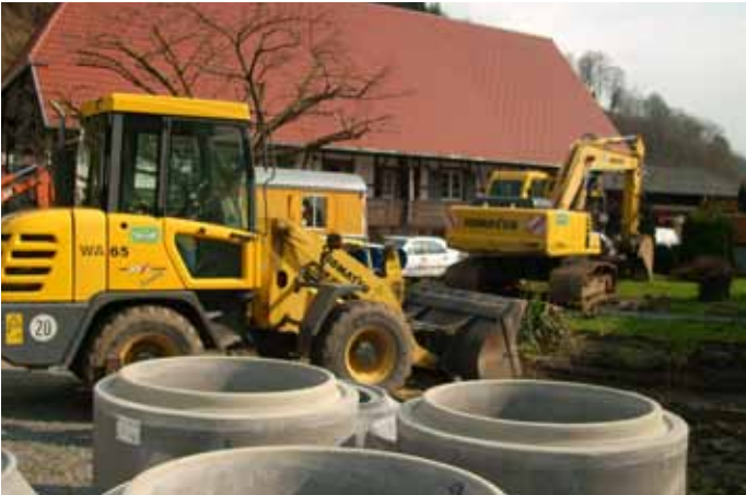
Außenarbeiten Outdoor works
