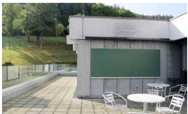
Neue Außentafel auf einer erneuerten Terrasse / New outdoor blackboard on a renewed terrace
